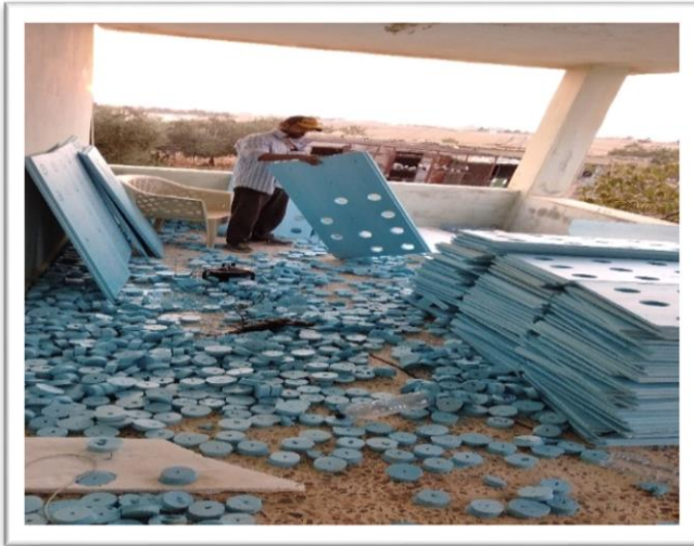
رسم توضيحي 40: تثقيب الواح البولسترين ( مؤسسة الجذور العالمية IRCAT) نل الرمان
